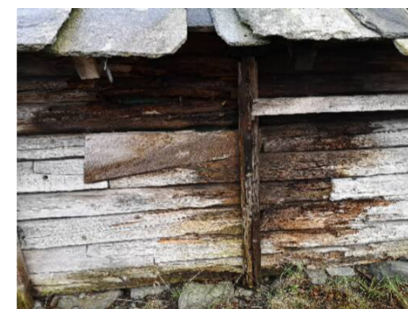
Prestanaustet før restaurering. Foto Kvinnherad kommune
