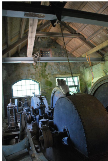
Valen gamle kraftstasjon. Foto Kvinnherad kommune
