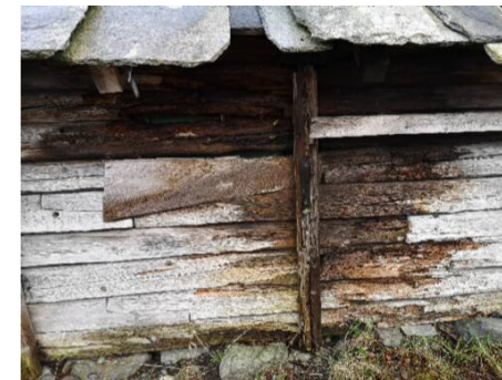
Prestanaustet før restaurering. Foto Kvinnherad kommune
