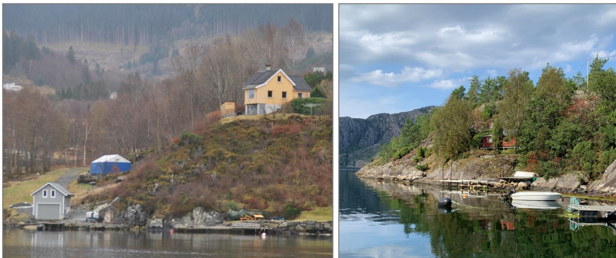
Figur 19. Venstre: Område med skredfare i sørvest. Høgre: Deler av område med skredfare i nordvest.
