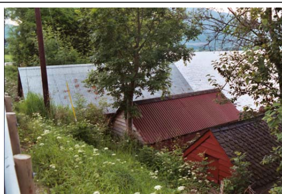
Figur 2. Tradisjonelle naust , delvis bygd inn i terrenget
