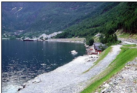
Etterkvart gror anleggsområda til Foto: HL
