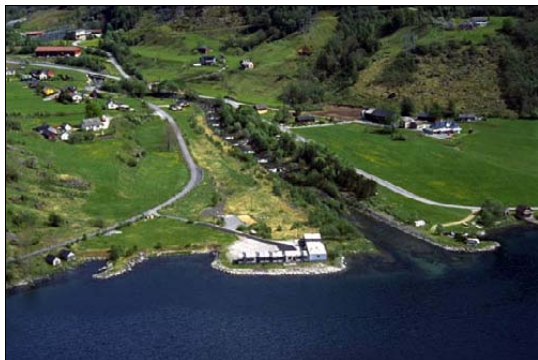
Kamrygg med Gjerde i bakgrunnen Foto: AH Elva er i ferd med å få frodig randvegetasjon.
