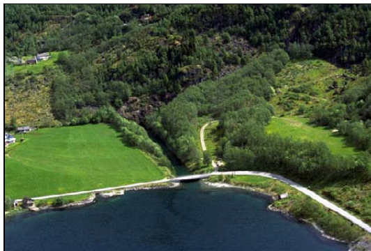
Kanalen frå kraftstasjonen Foto: AH Restar av eldre beitemark og hamnehagar.
