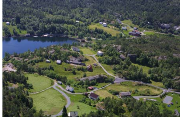
Figur 12. Vika ved Sjoangen i bakgrunnen. Busetnaden i framgrunnen ligg på eit platå lite synleg frå vika.
