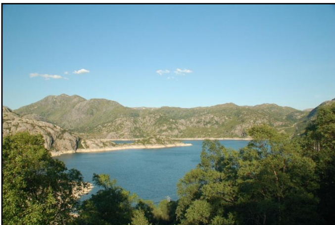
Bilde 50. Tydleg reguleringsrand langsmed vatnet. Veksling mellom tett skogsvegetasjon og blankskura bergflog er eit sentralt karaktertrekk.
