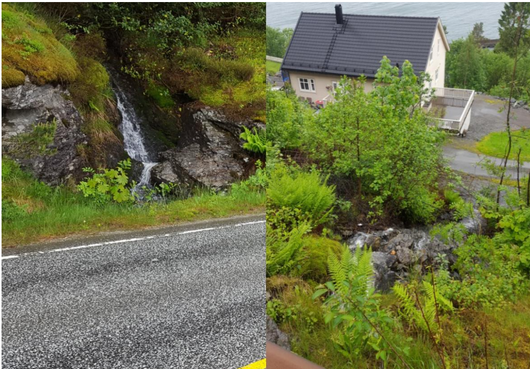
Bilde 1: Bekk ved profil 150 som krysser under fylkesvegen i stikkrenne.
