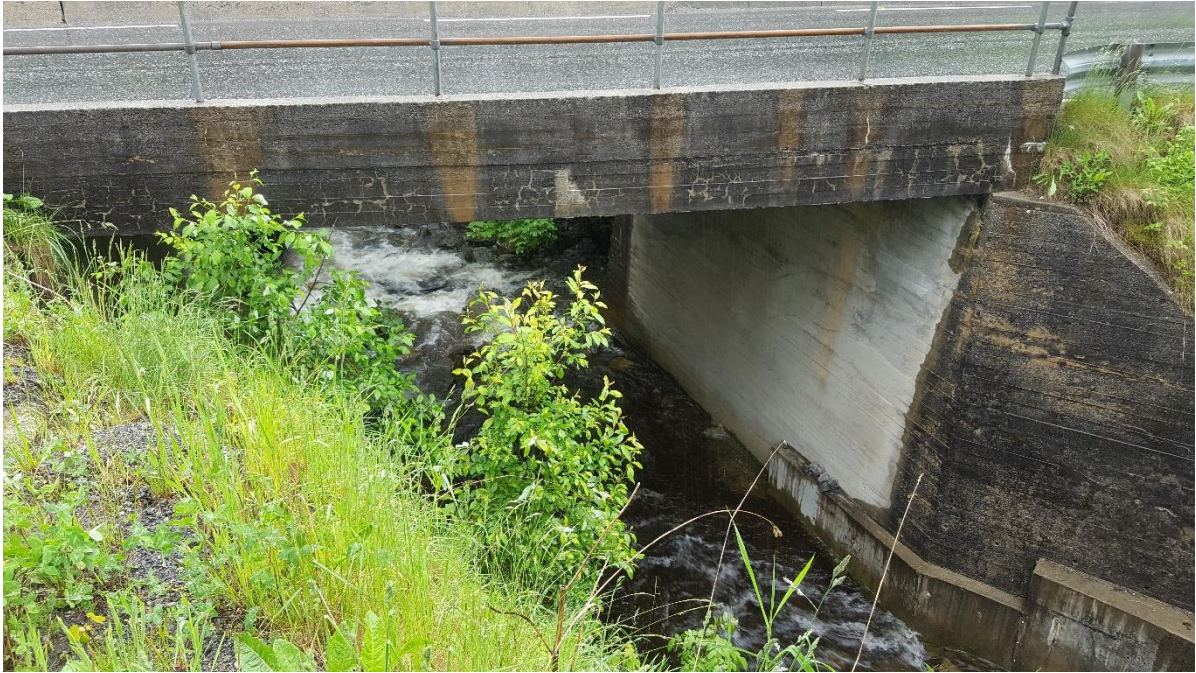
Bilde 2: Hellvikelva i kulvert under fylkesvegen ved profil 725.
