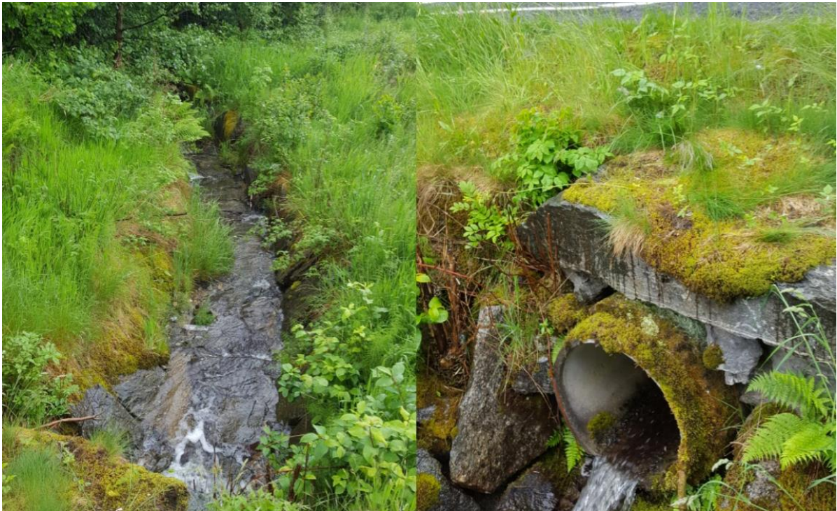
Bilde 4: Steinsatt bekkeløp nordvest for fylkesveg ved profil 1200 (t.h.) og utløp fra stikkrenne.
